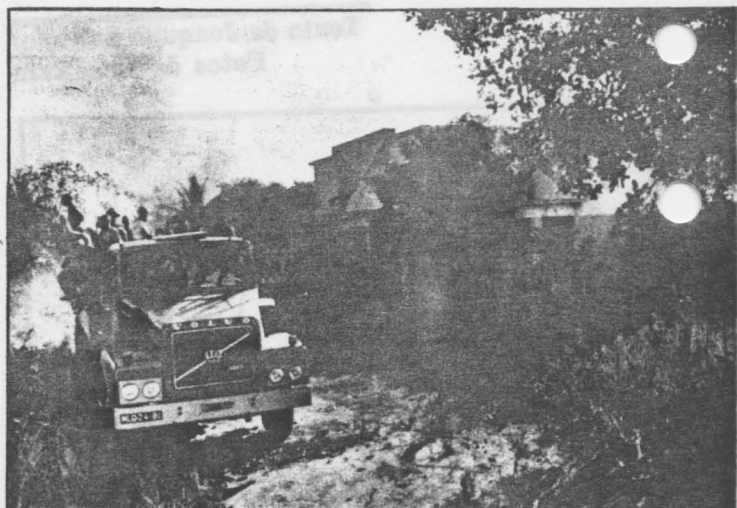
Infra-estruturas sociais e económicas que estavam em poder dos bandos vão ser reabilitadas por forma a permitir o regresso organizado das populações às zonas de onde os terroristas foram desalojados
