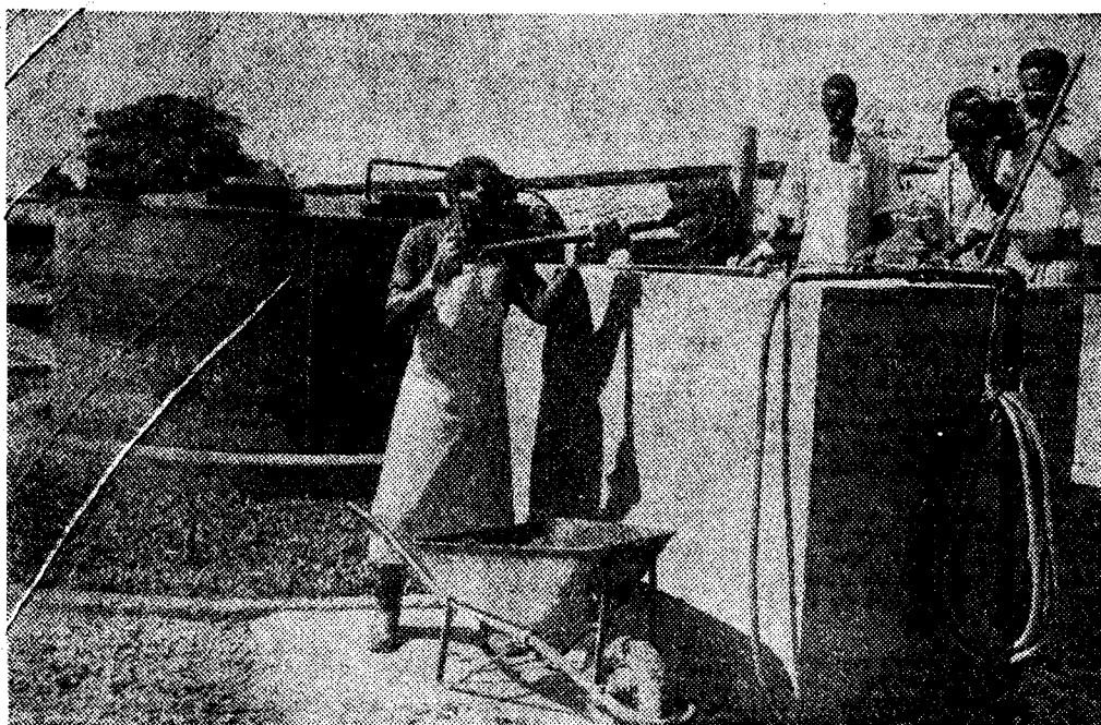
Processo de enchimento do tanque com dejectos de porco para a produção de biogás
