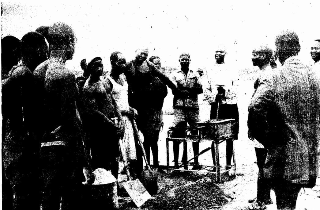
O pedreiro de camisola branca junto a máquina de fabricar blocos ensina aos camponeses da Aldeia Comunal de ODINEPA a arte de transformar areia e cimento em blocos. Este trabalho decorre no leito seco do rio Lúrio
