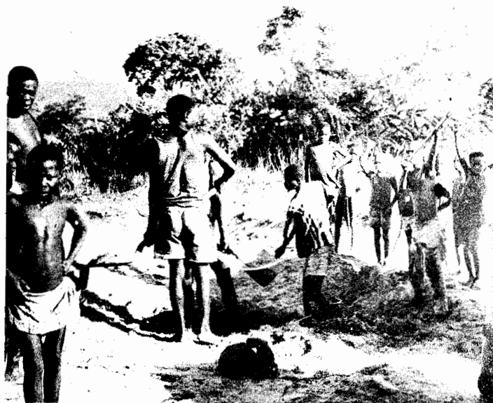
Até as crianças ajudam a tirar a areia para construção de blocos e para as misturas com cimento. Os camponeses fabricam 400 blocos por dia em MEJUCO.
